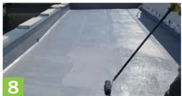
8 아크릭-우레탄 하이브리드 상도제를 도포 한다. ※두께 1mm 이하로 고르게 바른다.
