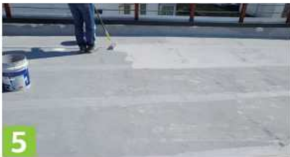
5 시트위에 함침제로 1차 도포 방수한다. 바닥까지 충분히 함침한다. ※ 물(약 20% ~ 30% 희석하여 사용)
