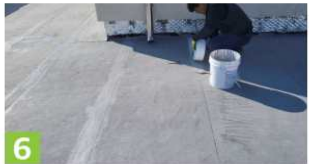
6 시트이음매, 조인 트부위에 고강도 보강시트(10cm) 부착 후 탄소섬유도료로 함침시켜 일체화 시킨다.
